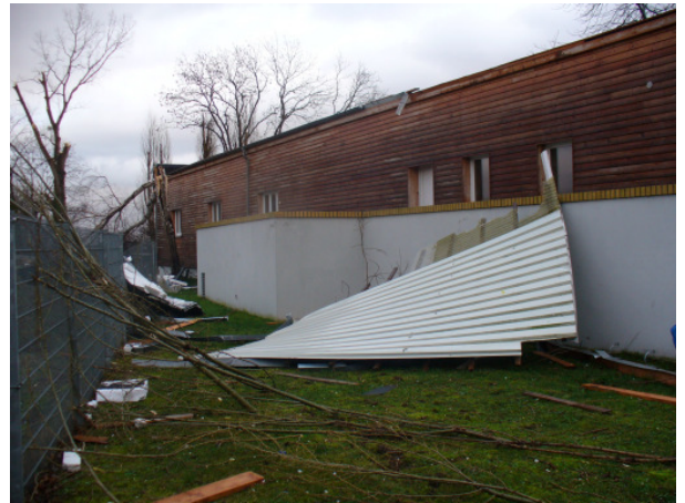
Dach vom Unterstand der Kanuten hinter dem Hauptgebäude
