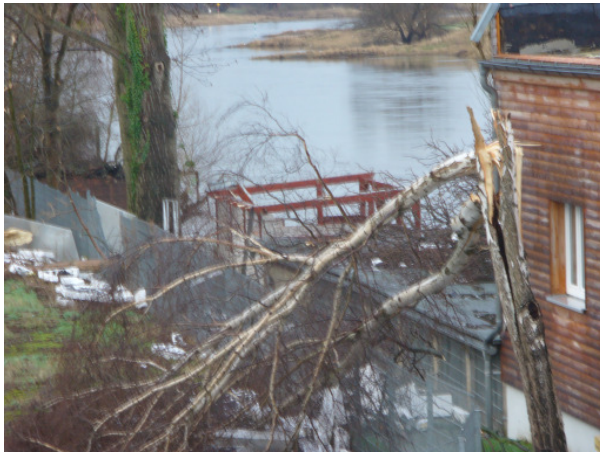
Boxenbereich der Segler mit abgedeckten und beschädigten Außenduschkplatz.
